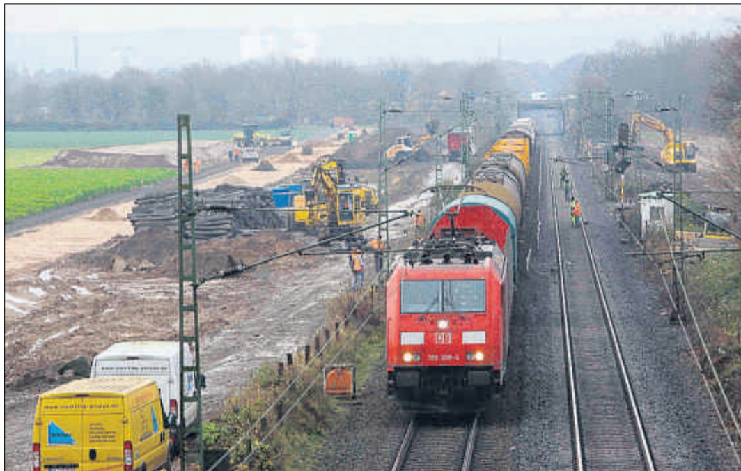
Die Vorarbeiten für die S 13 haben bereits begonnen. In Vilich wird ein Wirtschaftsweg (links neben der alten Bahntrasse) um 100 Meter verlegt. (Foto: Ralf Klodt)
